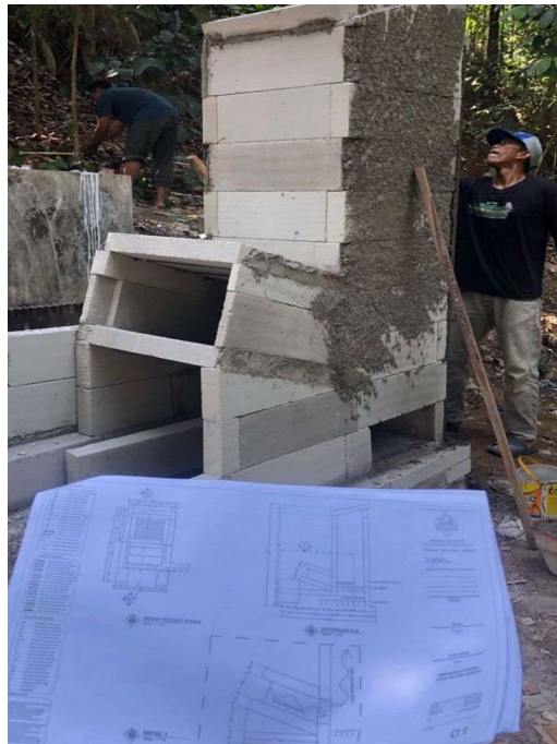
Gambar 4. Proses Pembangunan rocket stove sebagai teknologi pengelolaan sampah di Desa Randegan
