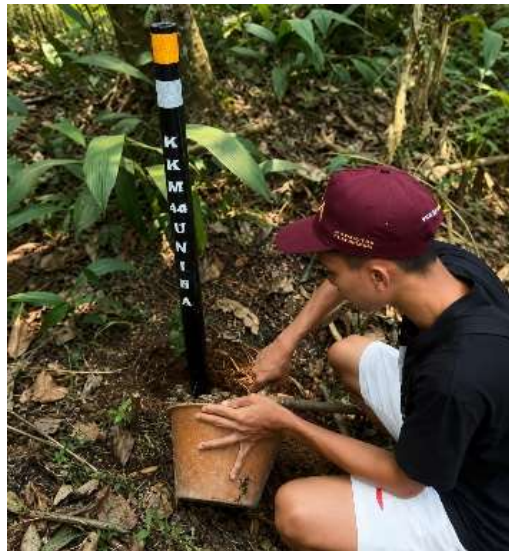
Gambar 3. Proses pemasangan reflektor jalan menggunakan bambu warga.
