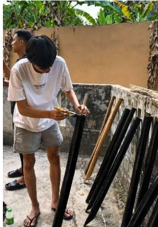
Gambar 2. Persiapan bambu sebagai media pendukung reflektor jalan.
