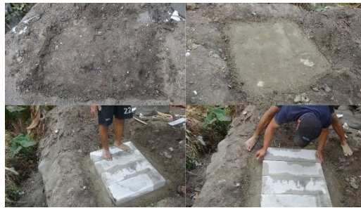
Gambar 7. Fondasi Awal Pembangunan
