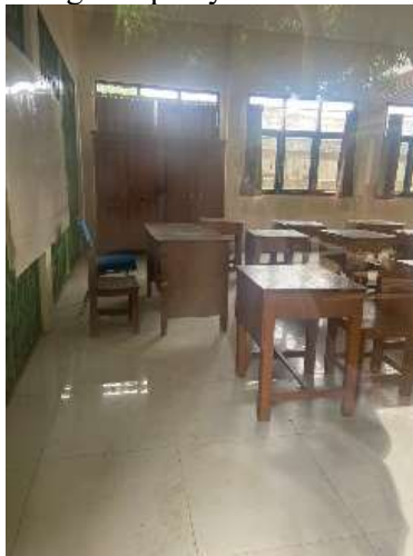
Gambar 1. Dokumentasi kondisi ruang kelas siswa SD Negeri 8 Talang Kelapa
