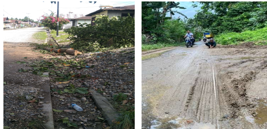
Gambar 4.1 Kondisi eksisting di lokasi penelitian dan kondidisi ruas yang tidak memiliki saluran. Sumber : dokumentasi survey 2024
