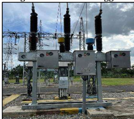
Gambar 2. PMT Bay Penghantar Ponorogo 1 GI Trenggalek[3]
