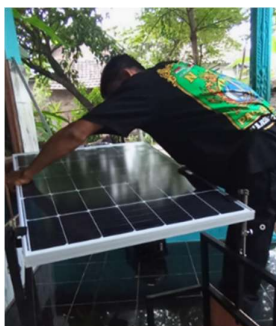
Gambar 2. Proses Pemasangan Panel Surya (Sumber: Dokumen Pribadi)
