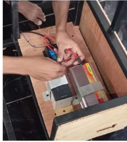
Gambar 3. Proses Pemasangan Scc (Sumber: Dokumen Pribadi)
