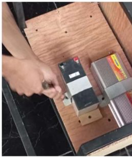
Gambar 4. Proses Pemasangan Baterai (Sumber: Dokumen Pribadi)
